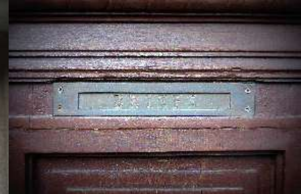
*Klapka zabezpieczająca otwór na listy
