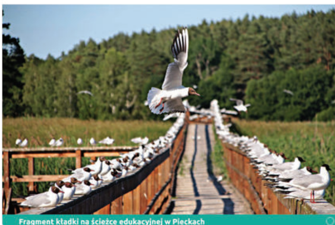
Fragment kładki na ścieżce edukacyjnej w Pieckach
