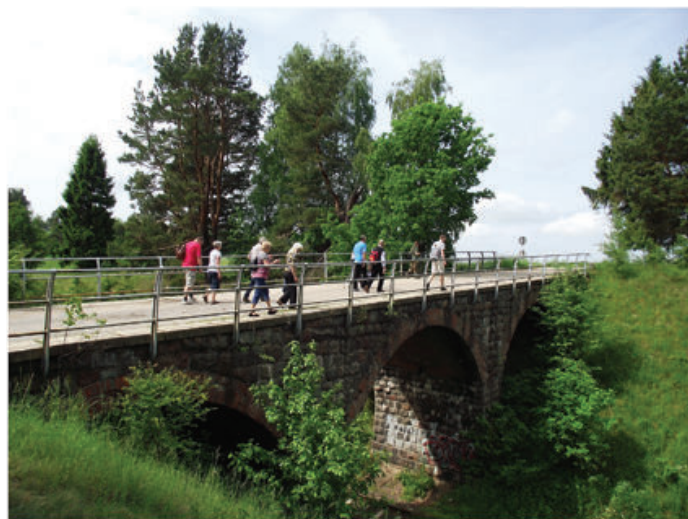
Most kolejowy w Nikutowie nad linią Mrągowo - Mikołajki
