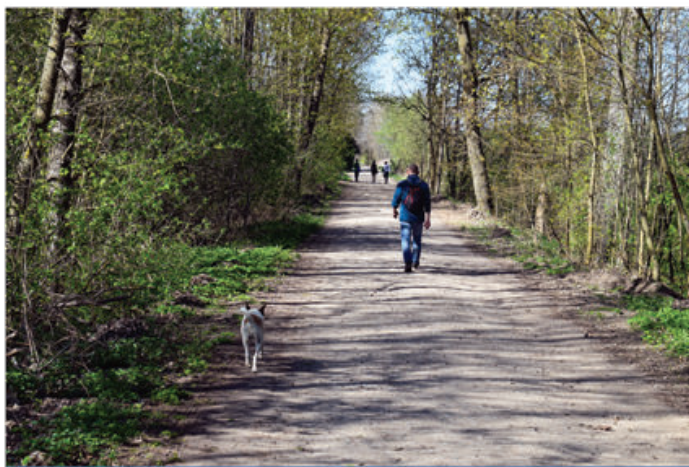
Nasyp kolejowy w Nikutowie
