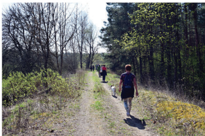
Nasyp kolejowy za Gwiazdowem
