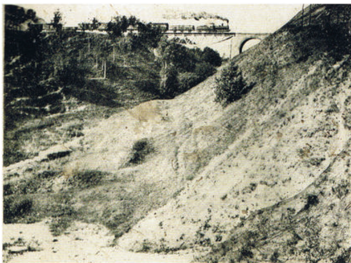
Przedwojenne zdjęcie mostu w Nikutowie
