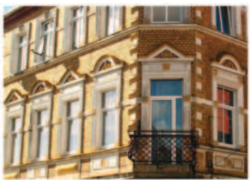
Mickiewicza 2. Fasada w górnych kondygnacjach pokryta jest cegłą. Dolna część jest boniowana. Nad oknami znajdują się naczółki tukowe i trójkątne.
