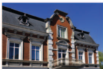
Kamienica z elementami barokowymi jak: ozdobne lukarna (okna dachowe) oraz falujące, otwarte zwieńczenie ryzalitu
