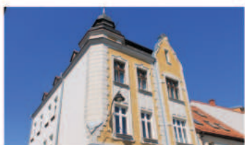
Plac Kajki 6. Spływające, zaokrąglone opaski okienne
